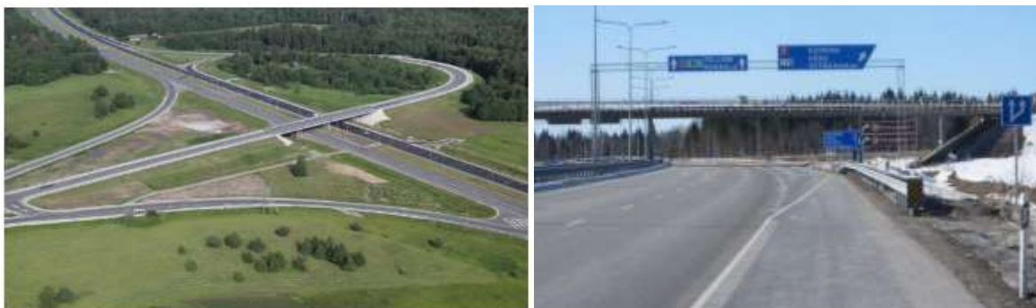
Pilt 17. Loobu viadukt (vasakul) ja Viitna möödasõidu viadukt (paremal)
