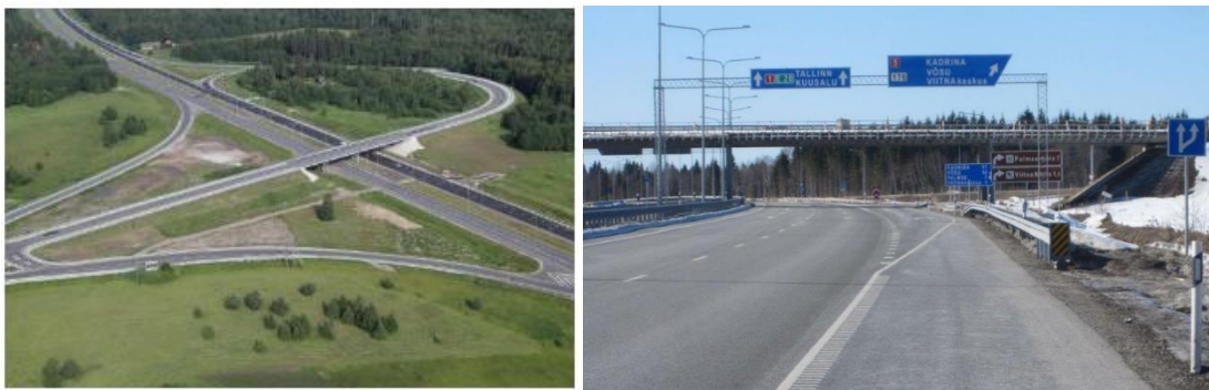
Foto 15. Viitna möödasõidu viadukt, Maanteeamet
