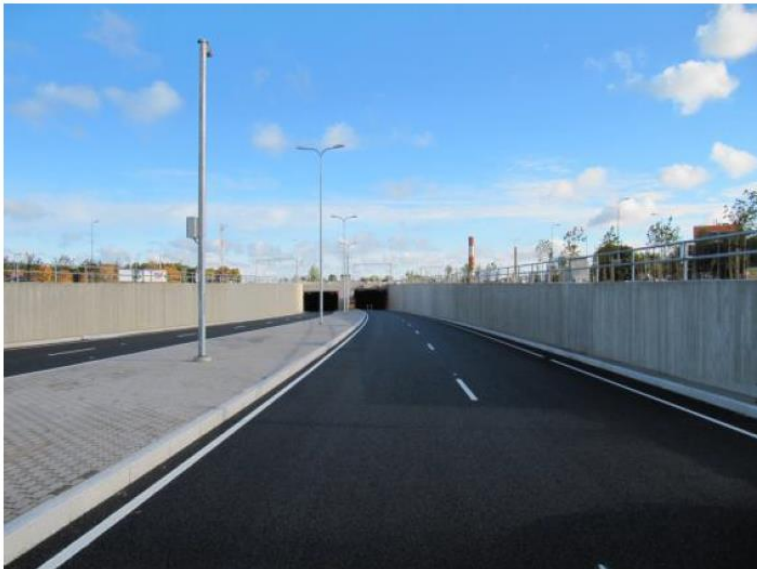
Foto 13. Sõidutee tunnel Järvevana tee ja Peterburi tee ühendamiseks, projekti lõpparuanne
