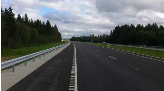
Foto 16. Valgejõe-Rõmeda rekonstrueeritud teelõik, Maanteeamet
