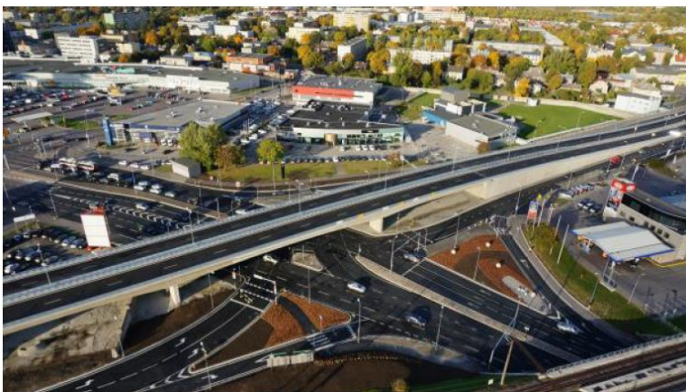
Foto 14. Vaade Peterburi tee viaduktile, projekti lõpparuanne
