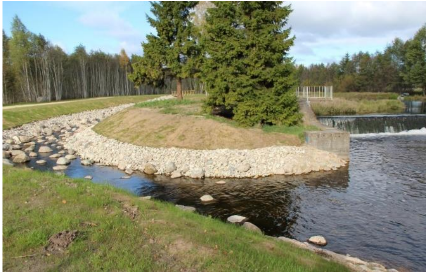
Pilt 5. Rutikvere paisule rajatud hajuskärestik-tüüpi möödaviikkalapääsu jõe paremkaldale. Põltsamaa jõgi Allikas: KIK (Projekti kogumaksmus 116 tuhat eurot)
