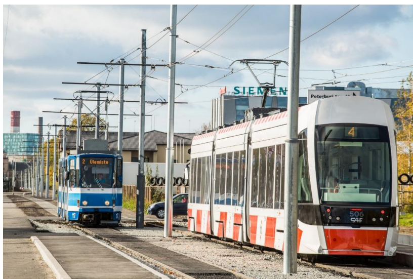
Pilt 12. II vooru projekti tulemusena betoonalusele viidud trammitee, mis võimaldab sellel lõigul kasutada uusi tramme. Pildil on näha vana ja uus, läbi kvoodimüügi soetatud tramm.
