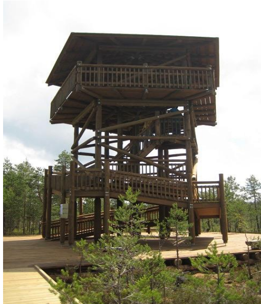
Pilt 15. Viru raba vaatetorn valmis projekti „Külastust suunava taristu rekonstrueerimine Lahemaa rahvusparkis“ raames (Kogu projekti maksumus 237 991,9 eurot. Toetus 100 %) Allikas: KIK
