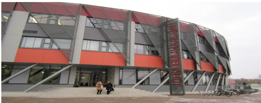
Pilt 42. Jõhvi Gümnaasium. Projekt „Regionaalse gümnaasiumi rajamine Jõhvi“. Projekti ERDF toetus 4 831 778 eurot, projekti kogumaksumus 5 684 445 eurot.
